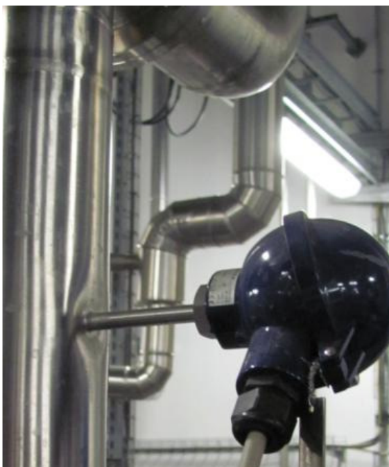
Fig. 4: Termorresistência compacta para orifício de solda Fonte: WIKA
