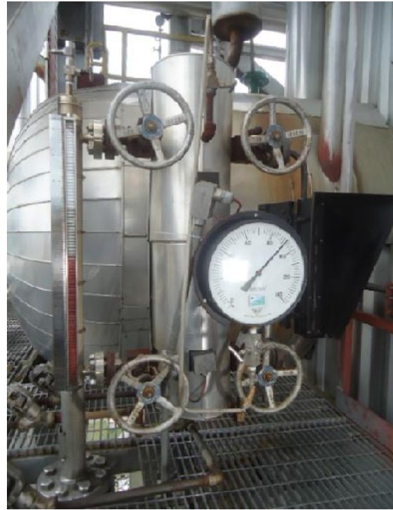
Medição de Nível no Tubulão da Caldeira
