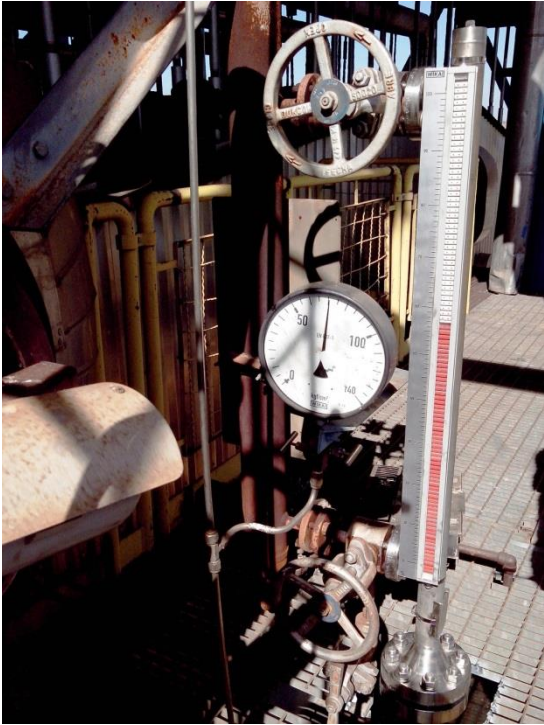
Medição de Nível no Tubulão da Caldeira
